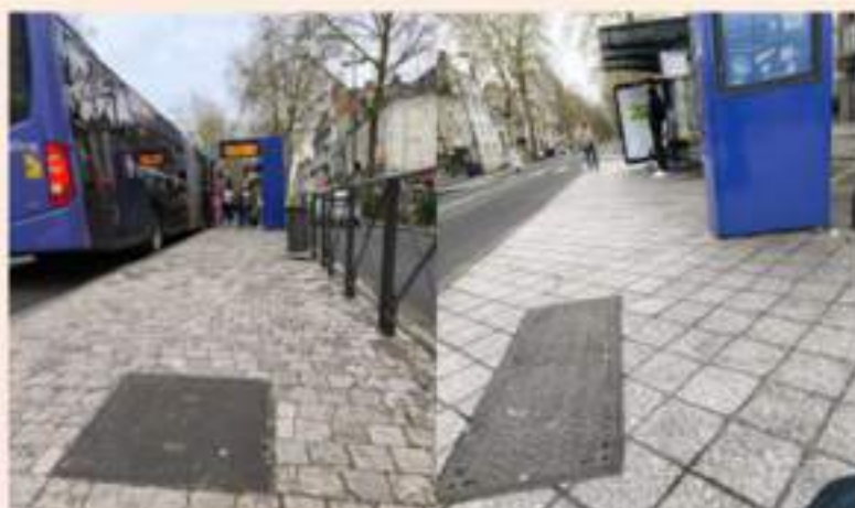
Photos de quais bus ligne 2 couverts de pavés
