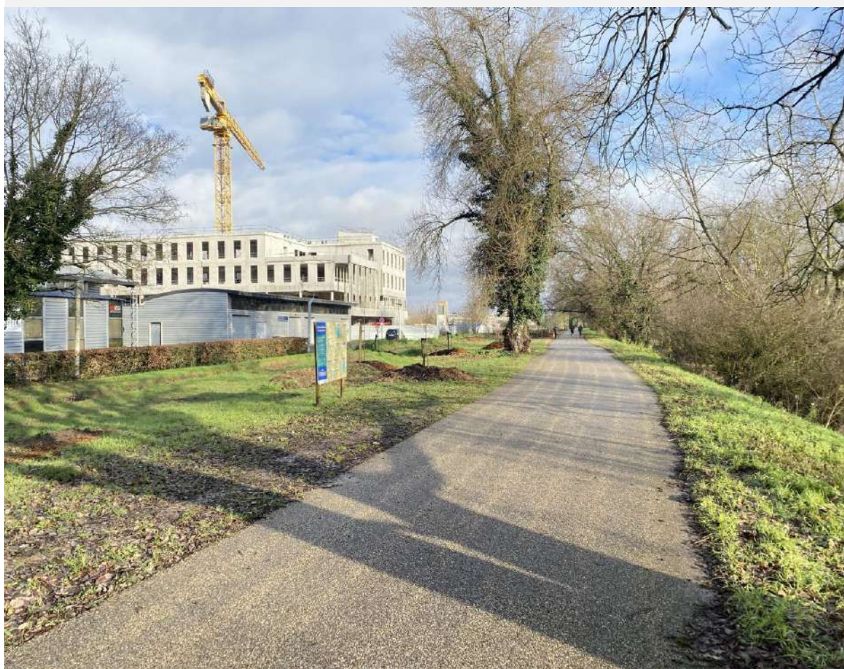
Emprise de l'ancienne voie ferrée de la Vendée à hauteur du quartier des 2 Lions à Tours (photo Mathis NAVARD)
