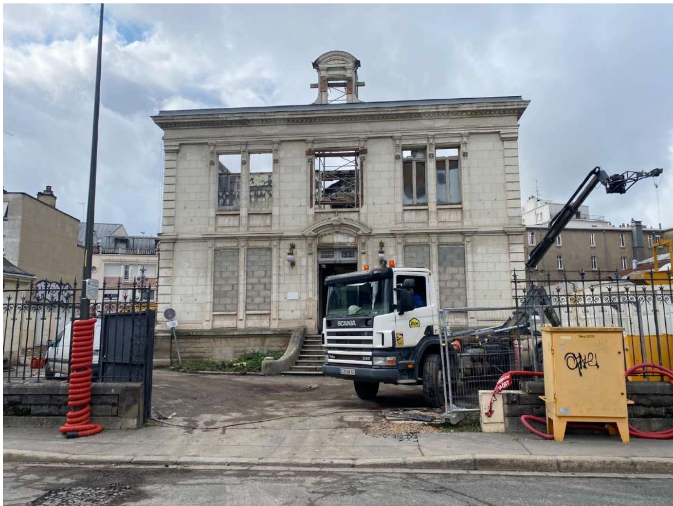
Transformation en résidence étudiante de l'ancien foyer cheminot à proximité de la gare de Tours (photo Mathis NAVARD)
