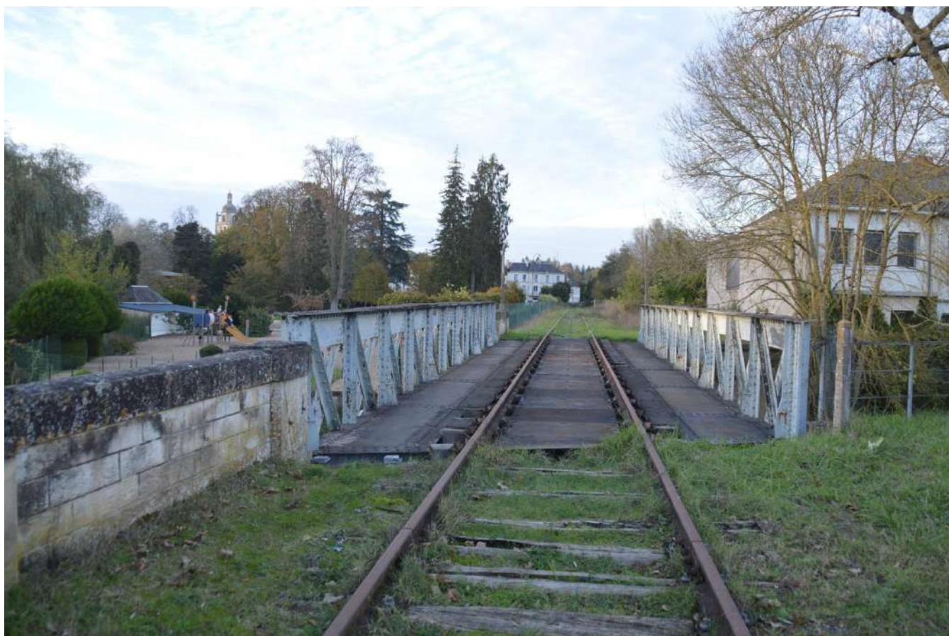
Tronçon abandonné de la voie ferrée de Tours à Châteauroux dans le centre de Loches (photo Mathis NAVARD)
