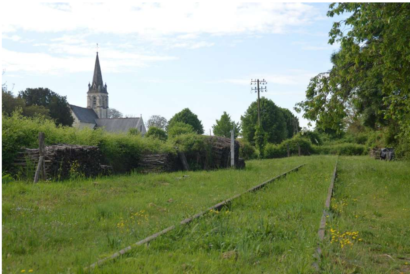
Tronçon abandonné de la ligne des Sables-d'Olonne en gare de La Roche-Clermault (photo Mathis NAVARD)
